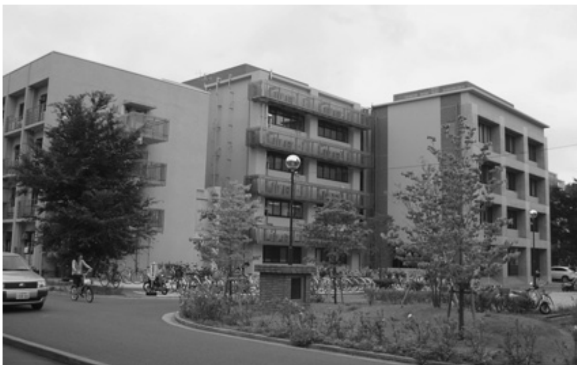
耐震改修工事を終えた人間健康科学系専攻校舎
